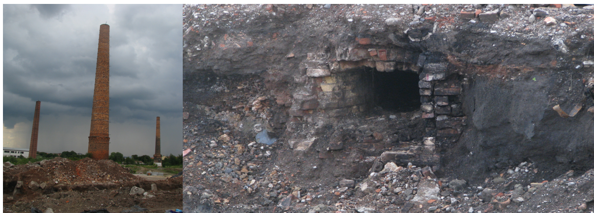
Slika 26: Deponija na območju stare cinkarne, potrebna sanacije (Foto: M. Suhadolc). Material je močno onesnažen s težkimi kovinami in organskimi onesnažili. V naključnem vzorcu tal so bile na primer vsebnosti Zn: 74000 mg/kg, Pb: 23000 mg/kg, Cd: 120 mg/kg, As: 1550 mg/kg; ter enega izmed policikličnih aromatskih ogljikovodikov (PAH) - fenatrena 25 mg/kg.
