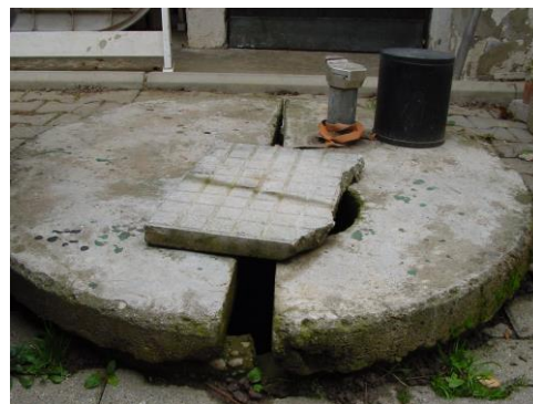
Slika 2. Merilno mesto Ključarovci na Murskem polju (upad podzemne vode v maju: 27 centimetrov)
