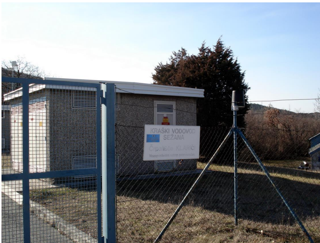
Slika 1. Črpalnišče pitne vode Klariči v Brestovici na Krasu; januar 2012 (Foto: N. Trišić)
