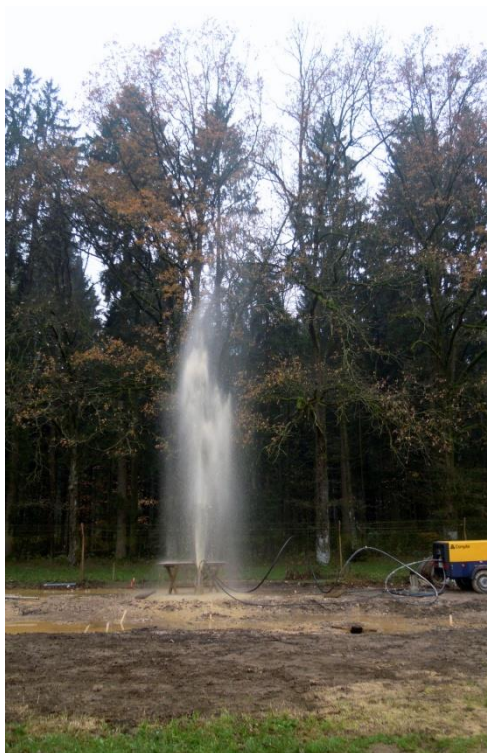
Slika 1. Aktivacija piezometra v Cerkljah na Gorenjskem; foto: V. Savić Figure 1. Piezometer activation in Cerklje na Gorenjskem; Photo: V. Savić
