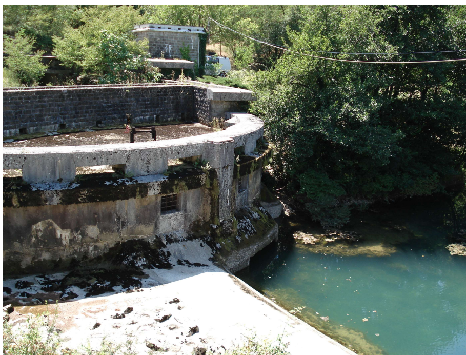
Slika 1. Glavni izvir reke Rižane se nahaja v kamniti zgradbi, ki je je najpomembnejši vodni vir za oskrbo prebivalstva s pitno vodo v Slovenski Istri (Foto: N. Trišič)
