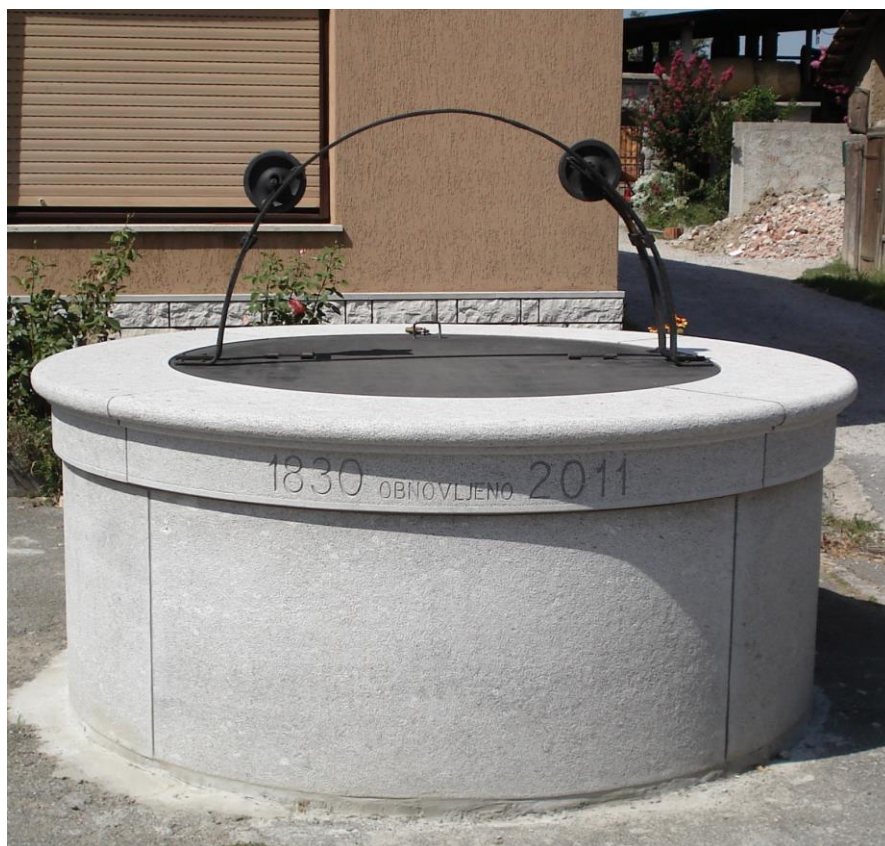
Slika 1. Obnovljen vodnjak v Vrtojbi: avgust 2011 Figure 1. Renewed well in Vrtojba: August 2011
