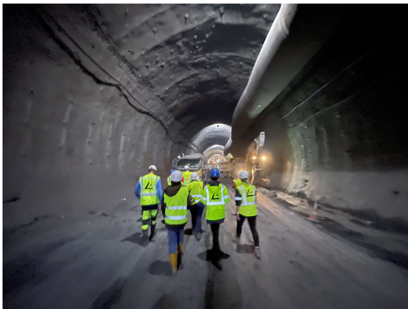
Slika 2. Izvedba vzhodne cevi cestnega predora Karavanke, ki izmed ostalih geoloških plasti prečka tudi obsežen dolomitni vodonosnik; oktober 2022 (Foto: U. Pavlič) Figure 2. Construction of the eastern pipe of the Karavanke road tunnel, which, among other geological units also passes an extensive dolomite aquifer; (Photo: U. Pavlič)
